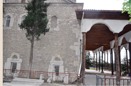
Hırka Camii Doğu Cephesi
